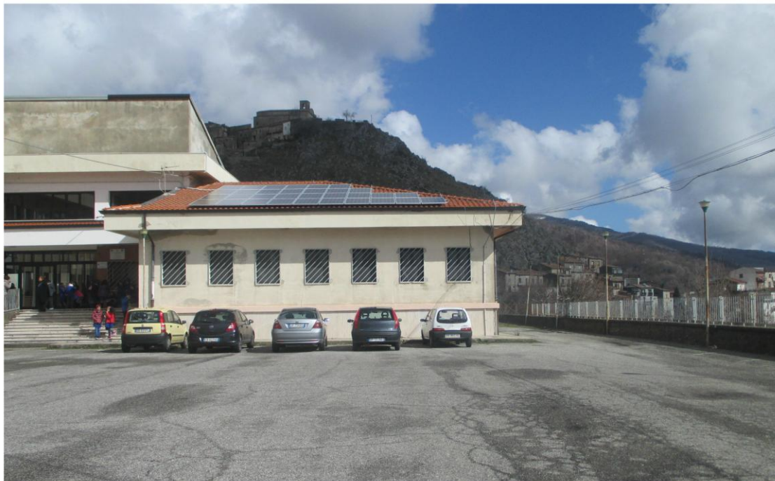
Edificio scolastico “L. Casella” loc. Cutura
